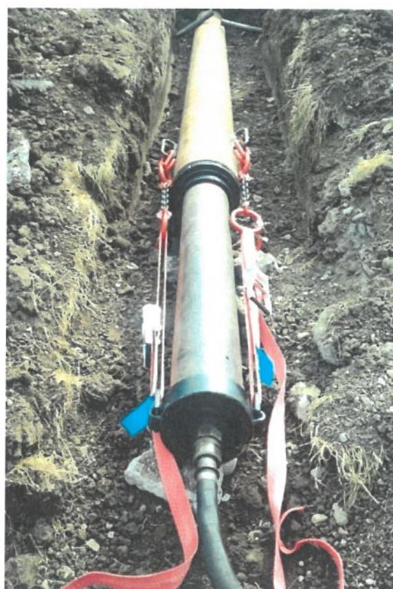
Foto 3 – Exemplificare - Extragerea pământului din tubul protector amplasat prin percuție
