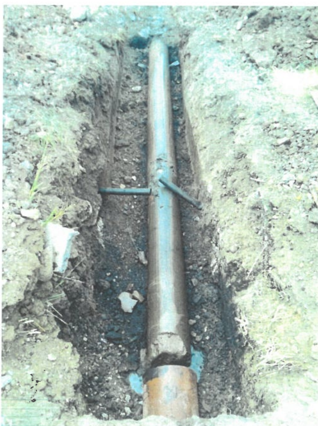
Foto 3 – Exemplificare - Extragerea pământului din tubul protector amplasat prin percuție
