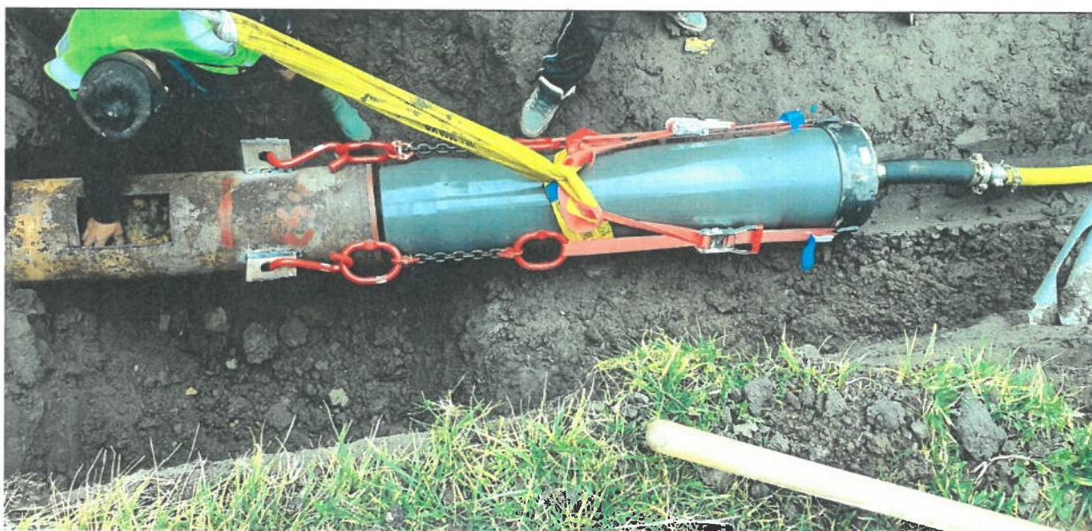
Foto 2 - Exemplificare ciocan de batere țevi montat pe tub protector
